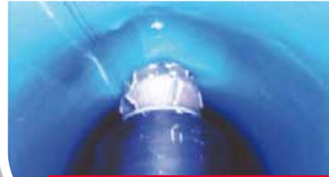
Fräsroboter im Einsatz
