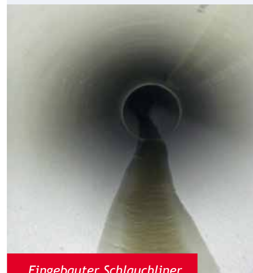
Eingebauter Schlauchliner
